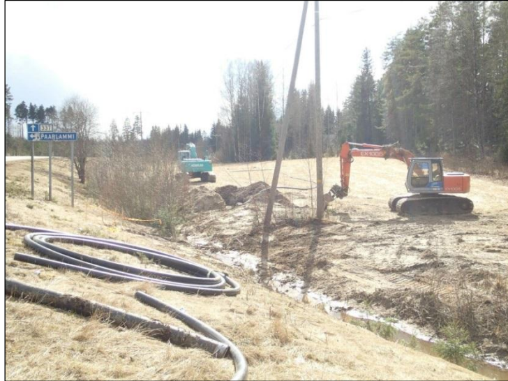
Kaivettua linjaa maantien 337 varrella Pihlajalahden Mäyräjärvellä
